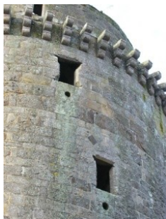
Fenêtres avec Canonnières
